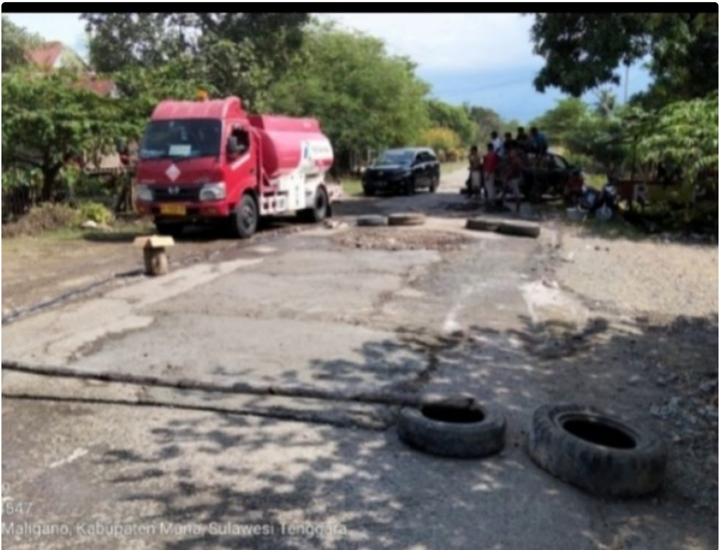
Kondisi jalan yang dicor oleh warga Maligano, Muna, Rabu (02/03/2022)
